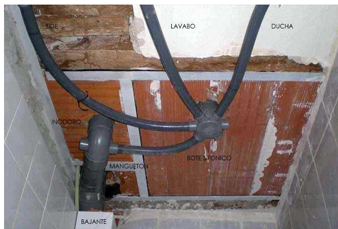
Fig. 49 Desagüe con bote sifónico.
