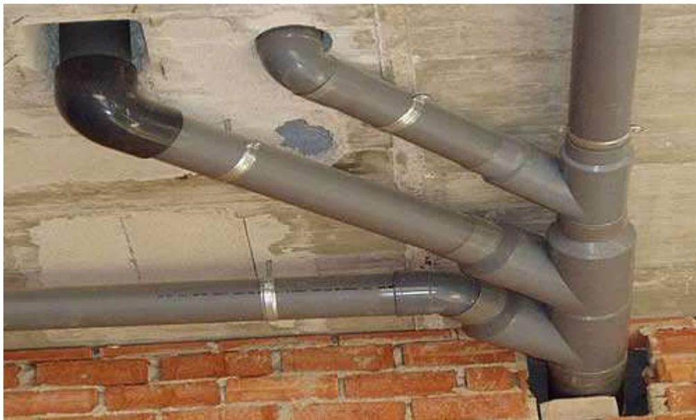
Hay que tener en cuenta siempre los elementos estructurales como vigas y pilares, con los que no puede haber interferencias, al contrario hay que evitarlos y por tanto que desviar los conductos. Esto marcará el nivel de acometida de los desagües a la bajante.
