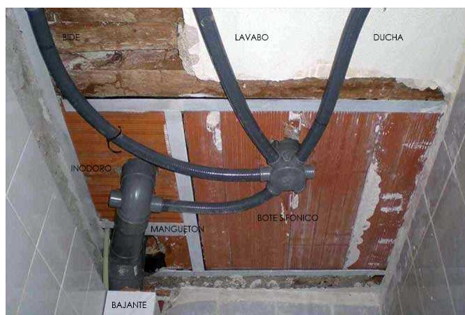
Fig. 49 Desagüe con bote sifónico.
